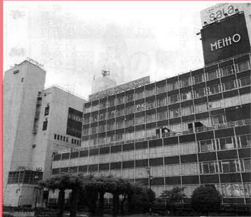
駅南地区にある名豊ビルと開発ビル
